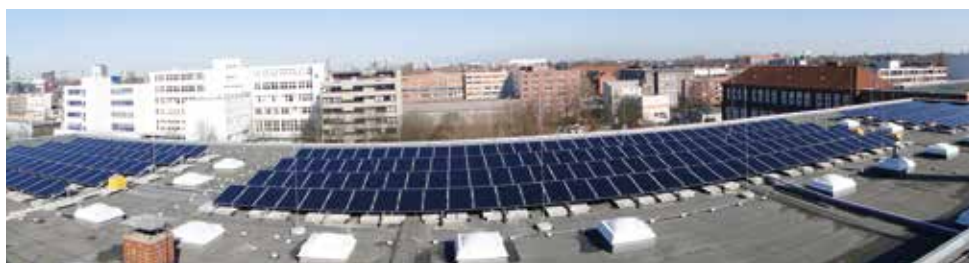
Solaranlage auf dem Dach der G 8
