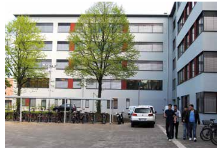
Neubau in der Budapester Straße
